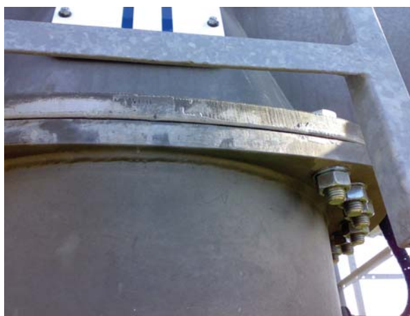
Obr. 1 - plocha páleného řezu
