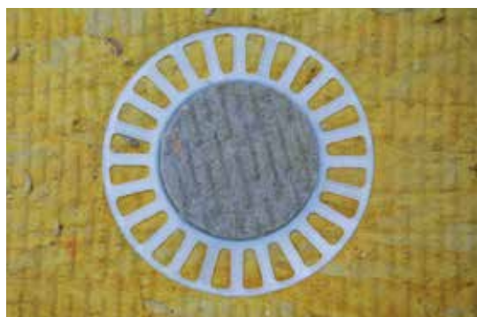
Obr. 3 - Systémová montáž s přídatným talířkem do MW
