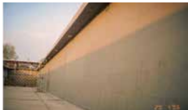
Obr. 3 - Slovnaft Bratislava – nátěr na kontaminovaný beton (jako adhezivní most na kontaminovaný beton nebo na beton se zbytky epoxidů)
