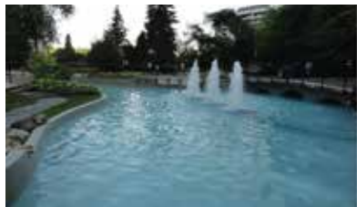
Obr. 2 - Fontána v Torontu, Ontario (v podloží bylo hodně spodní vody, pod fontánou tekla voda a klient chtěl jako vrchní vrstvu epoxid kvůli barvě a čistění, byly aplikovány cca 2 mm materiálu Cem-Kote Barrier Coat 100, pak epoxid, naprosťo funkční)
