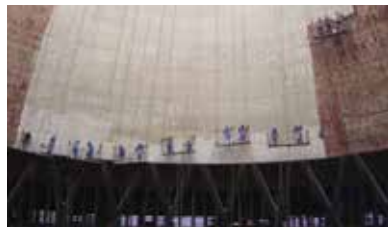
Obr. 4 - Chladicí věž v Číně (vodotěsnící vrstva, která drží na betonu se zbytkovým epoxidem)
