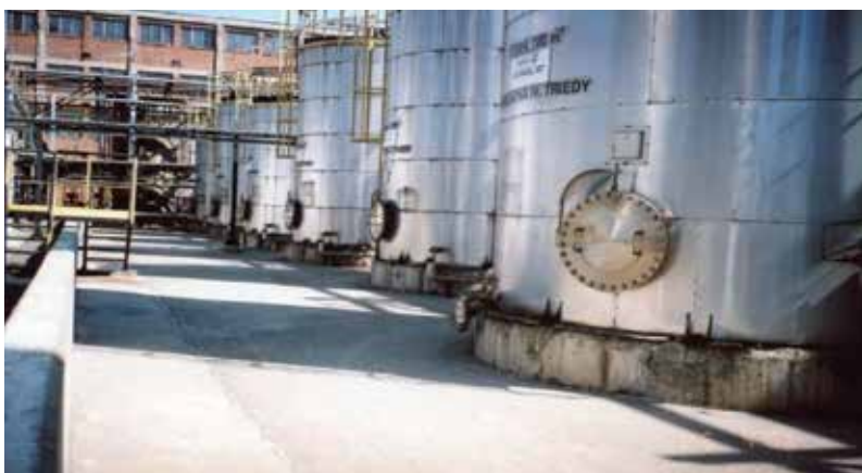
Obr. 1 – Nádrž na glykol – Nováky, Slovakia (příprava podkladu před aplikací epoxidu ve venkovní havarijní jímce)
