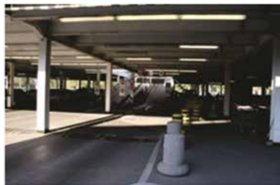
Obr. 2 - Aplikace na kovové konstrukci parkoviště ve Varšavě
