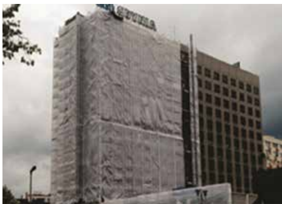
Obr. 4 - Kovová konstrukce a opláštění hotelu Gdynia (vlevo po aplikaci; v pravo původní stav)
