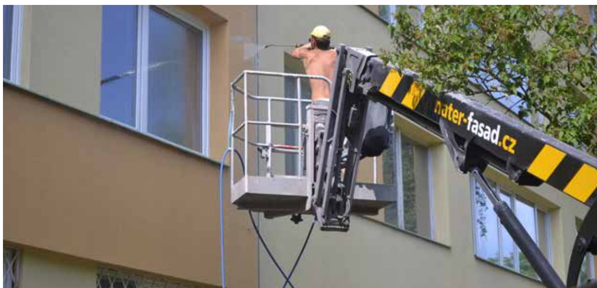
Obr. 1 - Aplikace systému na fasádě panelového domu
