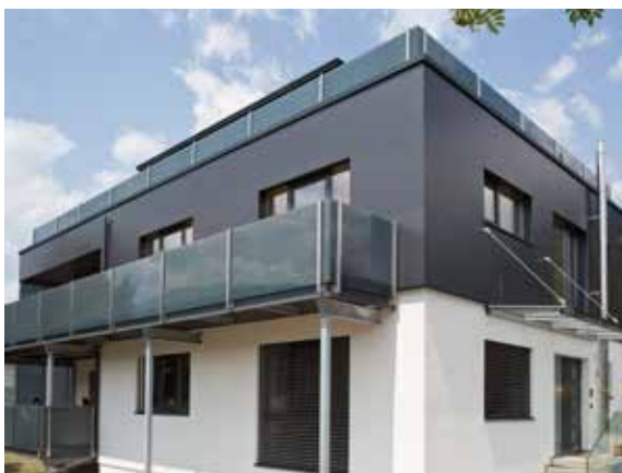
Obr. 4 - Velkoformátové PREFA kompozitní desky z barevného legovaného hliníku s jádrem z LDPE polyetylenu (Reynobond) v rozměrech 1500 x 4010 mm s celkovou hmotností 5,5 kg/m 2 se mohou lepit, nýtovat a šroubovat na hliníkový nebo dřevěný podkladní rošt
