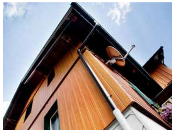
Obr. 3 - Prefa Sidings s optikou dřeva v kombinaci s bílou fasádní šablonou na horské chatě. Vhodné pro rekonstrukce s minimálními nároky na následnou údržbu
