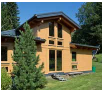
Obr. 1 - Zavěšený hliníkový provětrávaný fasádní systém Prefa Sidings lze montovat jak svisle, tak vodorovně ve třech různých šířkách (138, 200 a 300 mm) s příznanou nebo nepřiznanou spárou. Povrchová úprava stucco, hladká nebo linkovaná.
