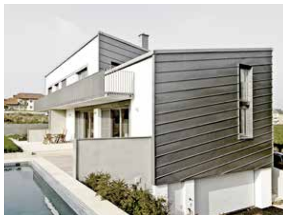
Obr. 5 - Úhlová stojatá drážka dává u hliníkového systému Prefalz fasádním prvkům osobitý vzhled. K dostání v mnoha odstínech s dvouvrstvným vypalovaným lakem P.10. Fasády ze svitkového plechu Prefalz vydrží po celou dobu životnosti domu
