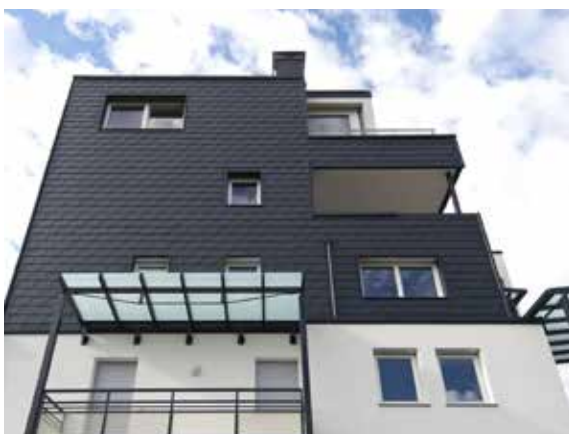
Obr. 6 - Fasádní šindel s typicky kosodelnikovým tvarem je vhodný pro malé a členěné plochy, tak pro velkoplošné fasády. Vysoce flexibilní a se zárukou 40 let na jakost materiálu a barvu
