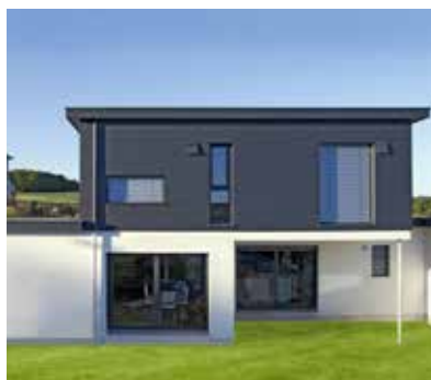
Obr. 1 - Zavěšený hliníkový provětrávaný fasádní systém Prefa Sidings lze montovat jak svisle, tak vodorovně ve třech různých šířkách (138, 200 a 300 mm) s příznanou nebo nepřiznanou spárou. Povrchová úprava stucco, hladká nebo linkovaná.
