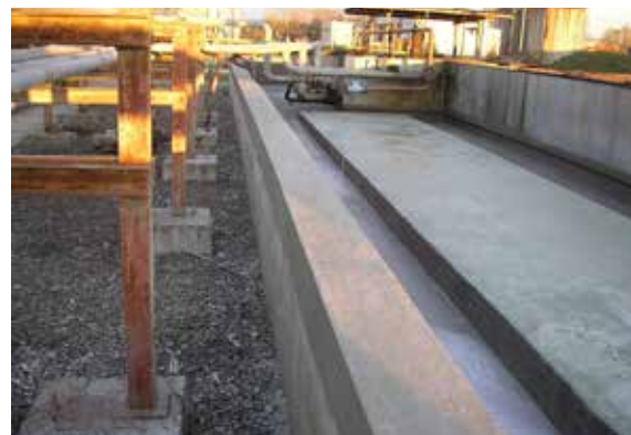
Obr. 4 - Stavba záchytné jímky na Slovensku
