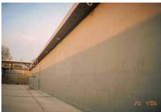
Obr. 10 - Dokončená vnitřní stěna nádrže
