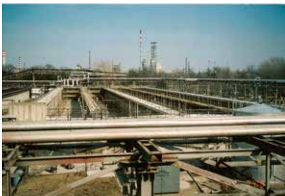
Obr. 7 - Čistička odpadních vod během oprav
