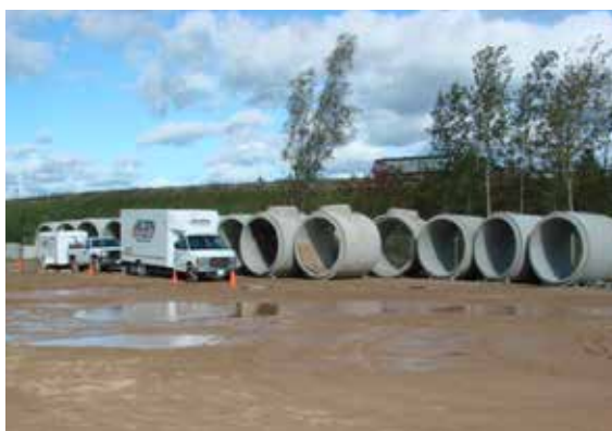
Obr. 2 - Betonové potrubí před výstavbou podzemní potrubní nádrže, New Brunswick, Canada
