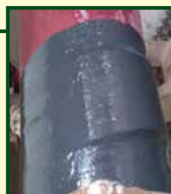
Opravené potrubí kompozitními materiály Resimetal
