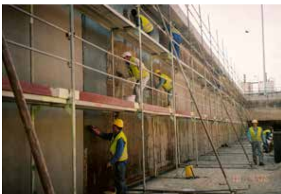
Obr. 9 - Aplikace spojovacího můstku Cem-Kote Barrier Coat 100 a Nano-Shield OSP
