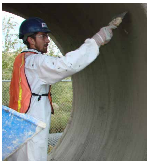
Obr. 1 - Aplikace Nano-Shield OSP na betonové potrubí, New Brunswick, Canada
