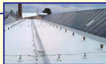
Střecha opravená materiály řady Membrane
