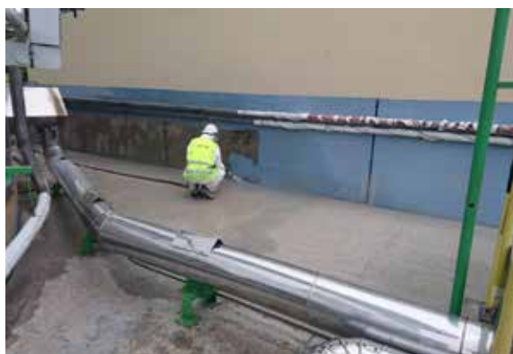
Obr. 5 - Betonová havarijní jímka na oleje, ČR
