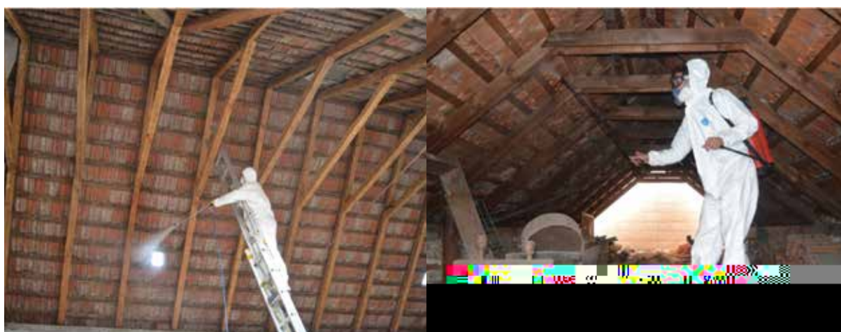
Obr. 10 - Fotodokumentace průběhu preventivní chemické ochrany dřevěných konstrukcí objektu
