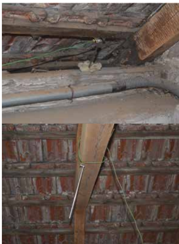
Obr. 3 - Fotodokumentace termoelektrických snímačů umístěných v sanovaném prostoru
