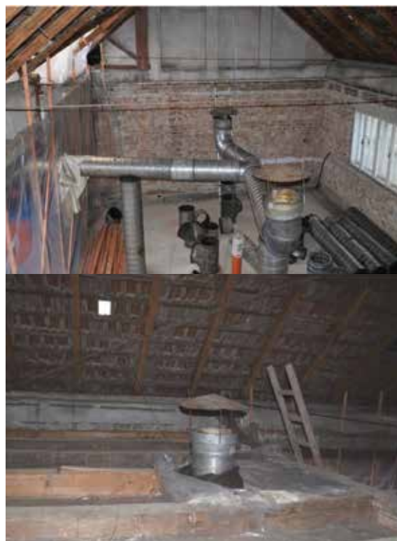
Obr. 2- Fotodokumentace rozmístění skládaného hliníkového potrubí pod krovovou konstrukci
