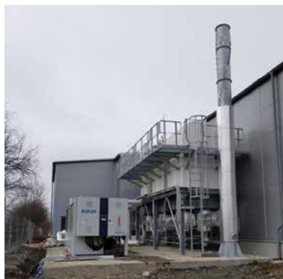
Obr. 5 – Zařízení pro likvidaci emisí
