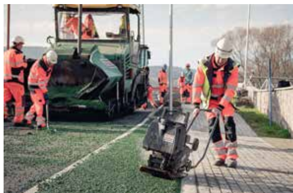
Obr. 5 - Pokládka barevné obalované směsi (zdroj: STRABAG, s. r. o.)
