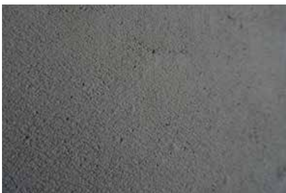
Obr. 5 – Struktura egalizační stěrky - hrubší zrnitost
