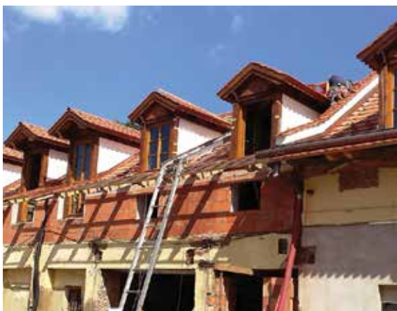
Obr. 15 - Rekonstrukce v roce 2017, II. etapa (09/2017)
