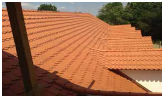
Obr. 12 - Tašková krytina na jižní straně (06/2017)
