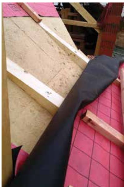
Obr. 6 - Klínové námětky nad římsou (11/2016)
