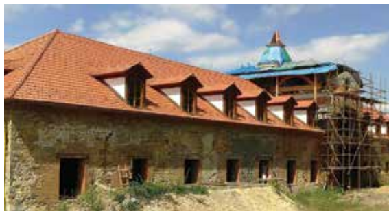
Obr. 14 - Pohled na severní stranu (06/2017)
