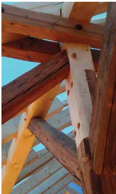
Obr. 5 - Detail spojení nových a starých trámů (09/2016)
