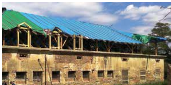
Obr. 8 - Zastřešení a první vikýře (08/2016)
