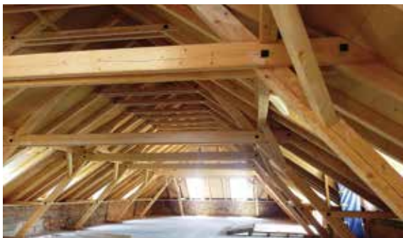
Obr. 11 - Pohled do interiéru pod střešou (06/2017)
