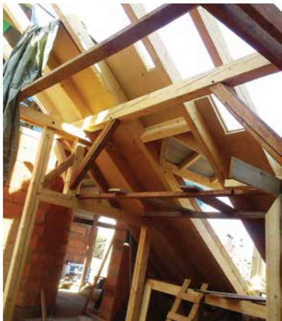
Obr. 9 - První desky Pavatex na střeše (09/2016)
