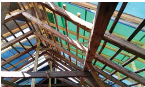
Obr. 3 - Původní krov, provizorní zastřešení (04/2016)
