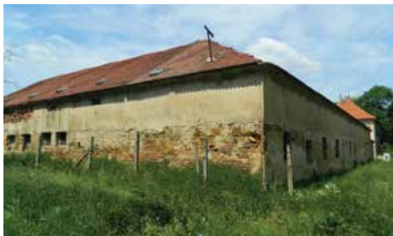
Obr. 19 - Jihovýchodní nároží dříve (archiv)
