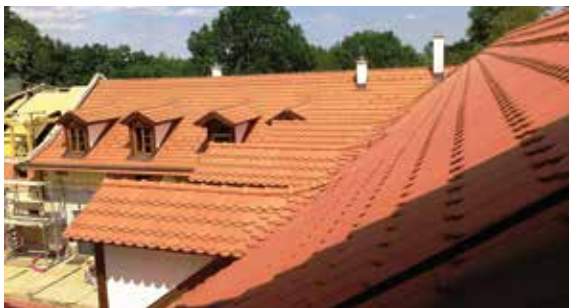
Obr. 13 - Jižní střeška směrem do dvora (06/2017)
