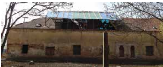
Obr. 2 - Částečně odkrytá střecha (04/2016)
