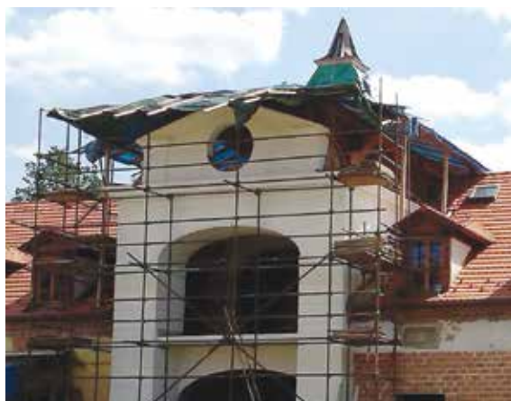
Obr. 16 - Nová výstavba, „věž“ (09/2017)
