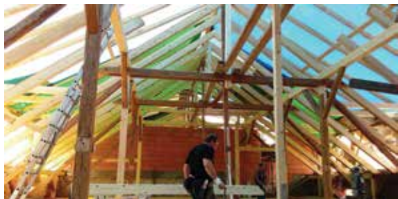
Obr. 7 - Nový krov s využitím některých původních prvků
