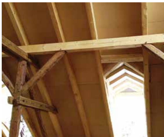
Obr. 10 - Zateplení při pohledu z interiéru (11/2016)
