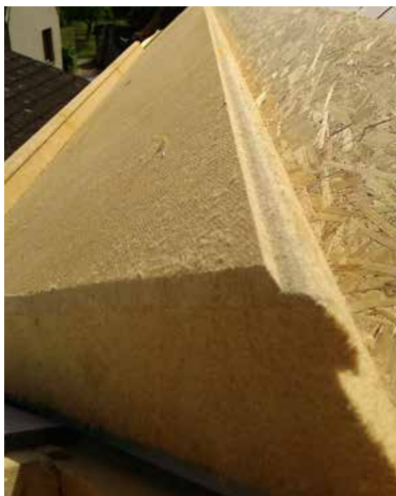
Obr. 7 - Detail Pavatherm-Plus v úžlabí
