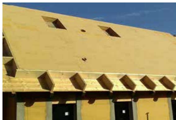
Obr. 12 - Kompletní zateplení jedné části střechy
