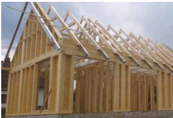
Obr. 9 - Sloupková konstrukce dřevostavby
