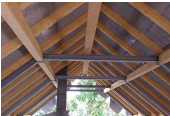
Obr. 5 - Interiér podkroví, ocel, dřevo a Powerpanel jako pohledový beton
