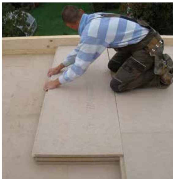
Obr. 2 - Montáž prostřední vrstvy Hofatex UD 100 mm
