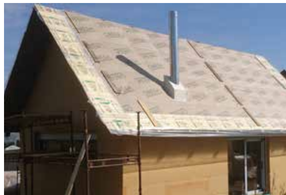
Obr. 10 - Palubkový záklop s parobrzdnou a vzduchotěsnou fólií
