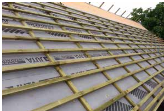
Obr. 8 - Střecha s pojistnou hydroizolací připravena pro střešní krytinu
