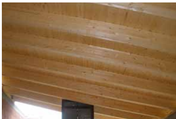
Obr. 1 - Palubkový záklop nad zděným bungalovem
