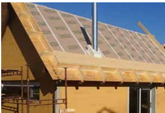
Obr. 11 - První řada desek ISOLAIR nad vyhřívanou oblastí střechy
