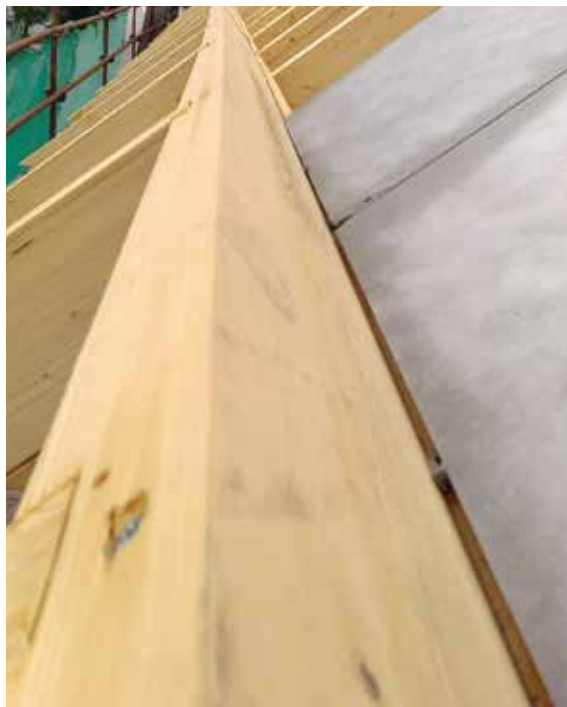
Obr. 6 - Powerpanel u okapové hrany
