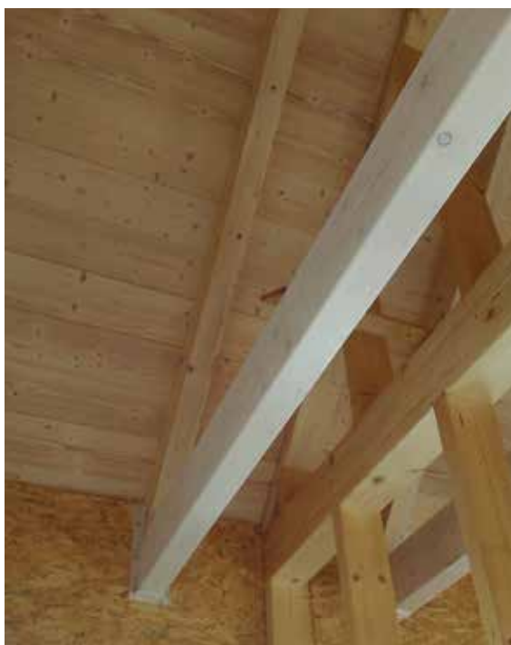
Obr. 13 - Pohled do nitra objektu, z budoucího obývacího pokoje do střechy (zdroj obrázků: archiv Inowool, s.r.o. a Ing. Školoud).
