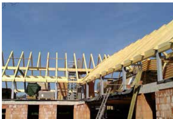
Obr. 4 - Nový krov z exteriéru
