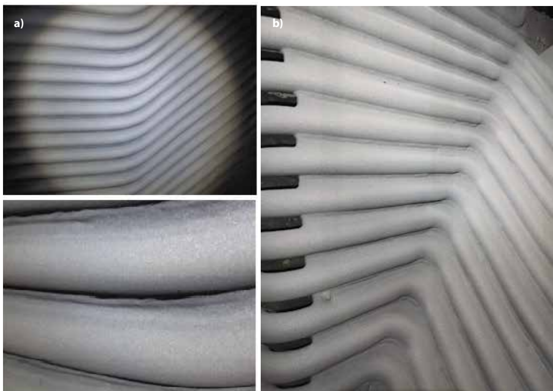
Obr. 7 – Dokončený žárový nástřik BTW 68: a) kolínek přední a zadní stěny spalovací komory, detail plochy s nástřikem b) sušek
