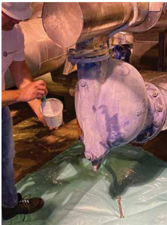
Obr. 1 – První adhezívní vrstva – adhezívní vrstva na horkém povrchu se dělá rozředěním nátěrové hmoty ALPHA TEMPER 1:1 s vodou.
