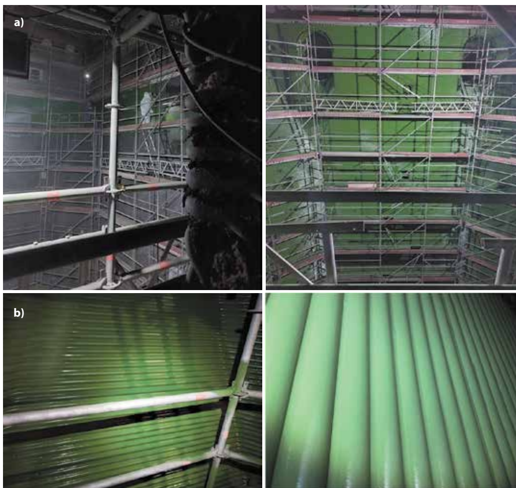
Obr. 8 – a) Pohled na spalovací komoru během a po aplikaci keramického nátěru TubeArmor, b) Detail plochy MeS po aplikaci keramického nátěru
