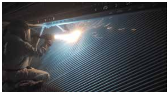
Obr. 4 – Žárový nástřik šikmých stěn výsypky, BTW 58, technologie AS
