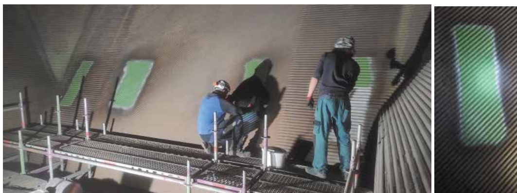
Obr. 3 – Zajištění povrchové úpravy pod patky lešení, žárový nástřik BTW 58 + keramický nátěr
