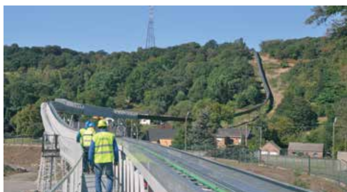
Téměř 20 tisíc m 2 povrchových úprav 1,8 km dlouhého příhradového dopravníku elektrárny LES AWIRS v Belgii
