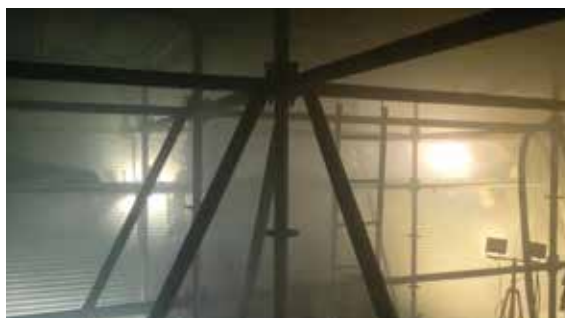
Obr. 5 – Nástřik výsypky pod záklopem, BTW 58, technologie AS
