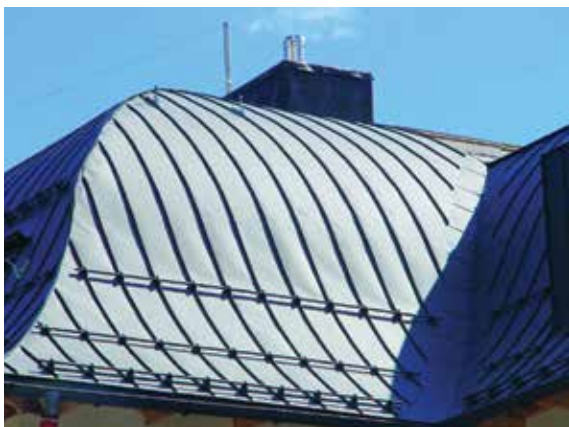
Obr. 4 – Střešina byla projektantem ušita na míru
