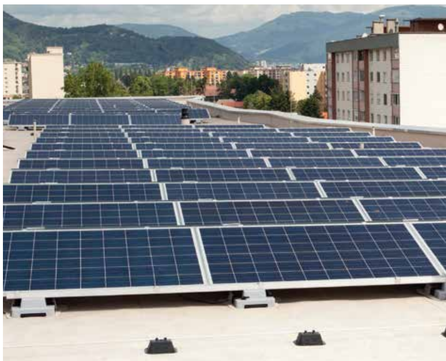
Obr. 4 – Přikotvení fotovoltaických panelů k PVC fólii pomocí systému SolarMount
