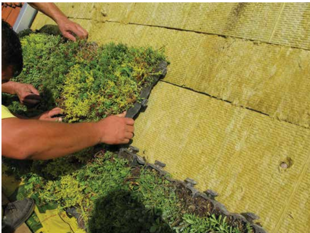
Obr. 1 – Ukázka pokládky zelené střešy
