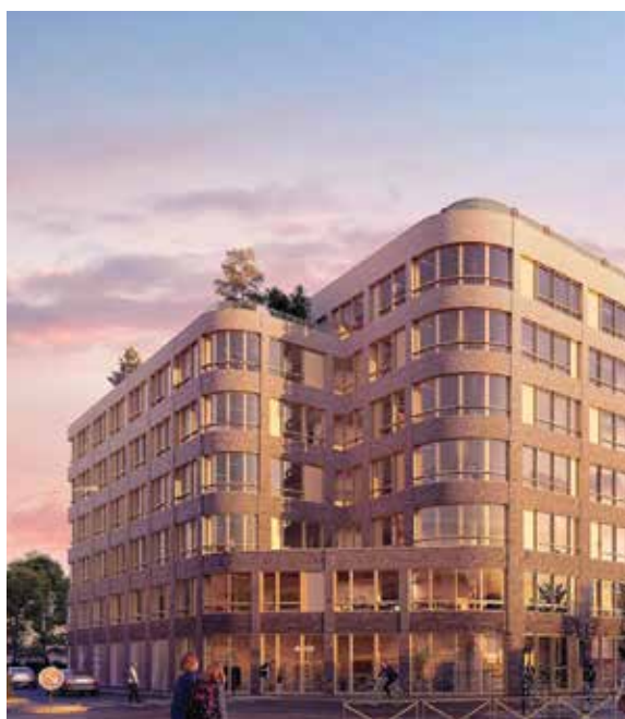
Obr. 1 – Kancelářská budova Kalifornia v Paříži
