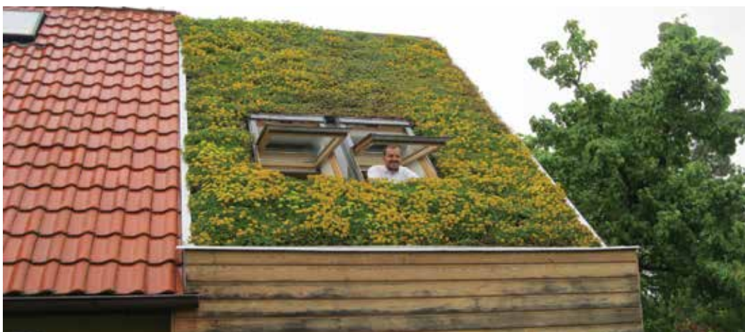
Obr. 3 – Extenzivní zelená střecha na rodinném domě u Prahy
