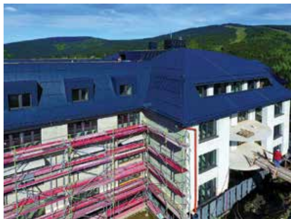
Obr. 3 – Na obnovu střešiny se použilo 1500 m 2 střešiny krytiny
