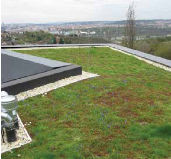
Obr. 2 – Zelená střecha na kancelářské budově v Praze
