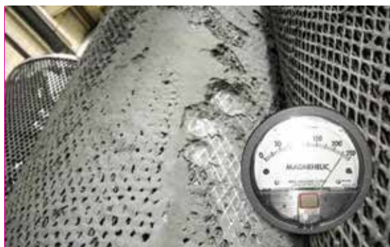
Obr. 3 – Ucpaný filtr
