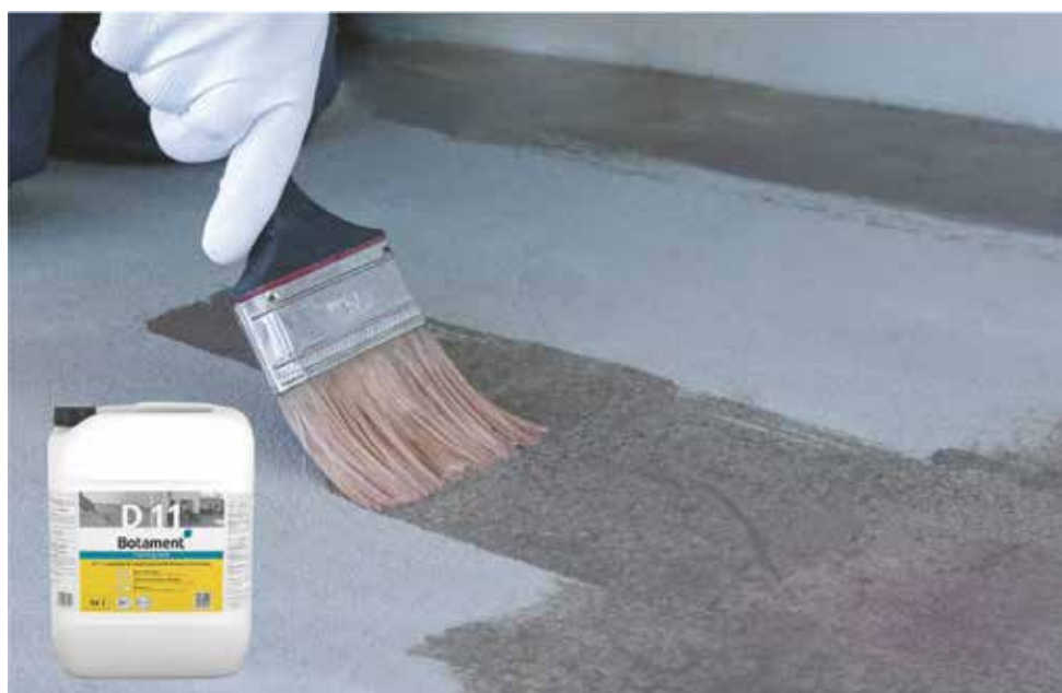
Obr. 5 – Nasávkavý podklad se opatří penetračním nátěrem D11
