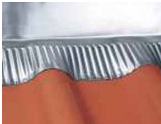
Obr. 2 – Spodní díl plechování komínu měkkým zinkem „plizovým“
