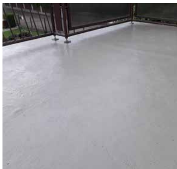
Obr. 7 – Celoplošná membrána
