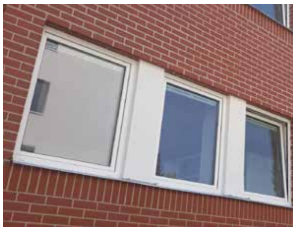
Obr. 2 – Opláštění budovy je tím prvním, co na objektu vidíme
