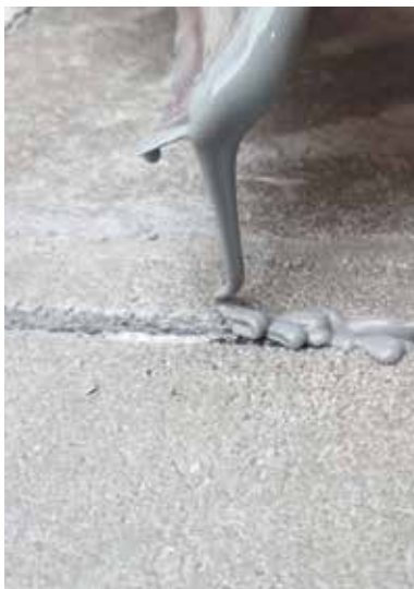
Obr. 4 – Zalévání spár
