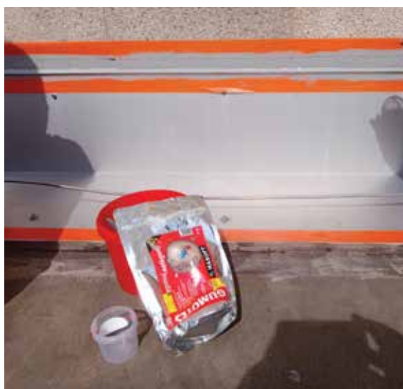
Obr. 2 – Utěsnění klempířských spojů
