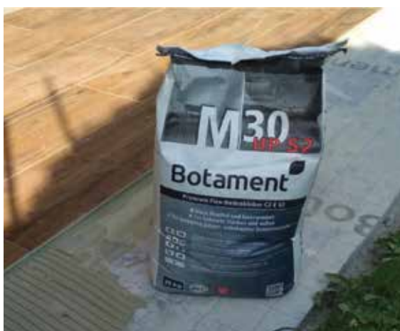
Obr. 2 – Pokládka dlaždic do lepidla M30 HP S2
