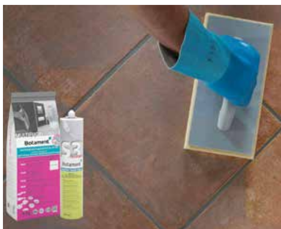
Obr. 1 – Spárování hmotou MULTIFUGE® Fine Speed, dilatace S3 Supax
