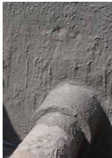
Obr. 5 – Utěsnění prostupů
