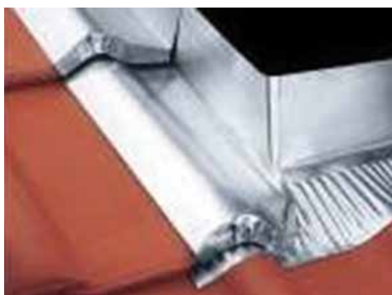
Obr. 1 – Spodní roh plechování komínu měkkým zinkem „hladkým“ a „plizovým“
