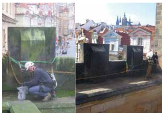
Obr. 4 – BALCLEAN a světlo chrání ochoz malostranské Mostecké věže před zezelenáním. Vlevo původní stav, vpravo po ošetření
