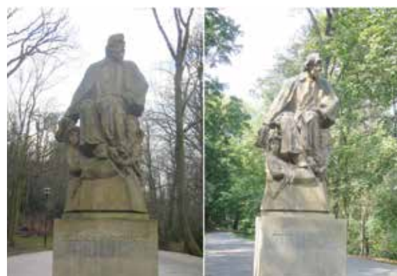
Obr. 5 – Socha Jaroslava Vrchlického na Petříně preventivně ošetřená systémem Balclean na památce, vlevo původní stav, vpravo tři roky po aplikaci
