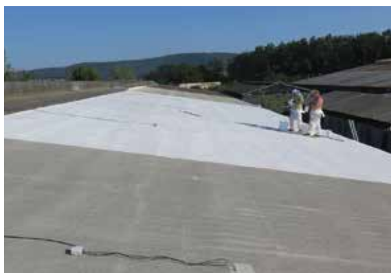
Obr. 8 – Testování účinnosti patentovaného tepelně stabilizujícího povrchu Albedo na střeše kravína v areálu ZD Mořina
