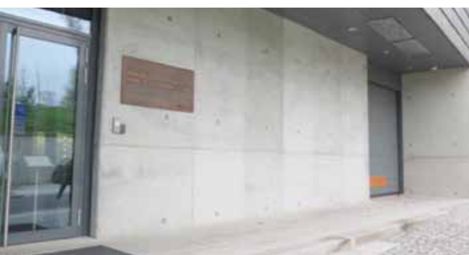
Obr. 2 – Nátěrový systém Balclean aplikovaný na každém sudém betonovém poli vchodu do nanotechnologického centra TUL prokazuje samočisticí funkci i čistící funkci od NOx v nejbližším okolí
