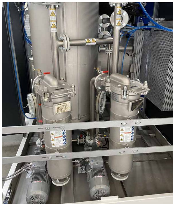
Obr. 3 – Vertikální integrace dvou standardních zaplavovacích nádrží snižuje tvorbu usazenin a zabraňuje vzniku kapes s nečistotami, což vede k delší životnosti lázně. K tomu u verzí L a XL přispívá také zvýšený výkon destilátu až 180 l/h a standardně dodávané plynulé vypouštění oleje. Zdroj: Ecoclean GmbH
