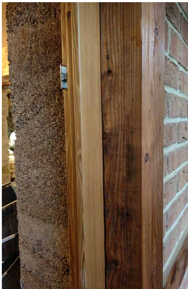
Fasáda z cihlových pásků na domě z konopného betonu
