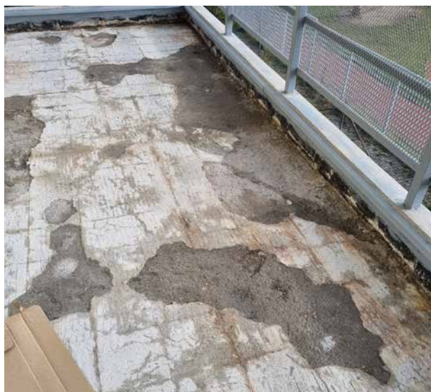
Obr. 1 – Po důkladném očištění podkladu následuje aplikace penetrace, která sjednocuje savost a zajišťuje správnou přilnavost dalších vrstev. Menší defekty je vhodné dorovnat pomocí mrazuvzdorného rychlobetonu C 30.
