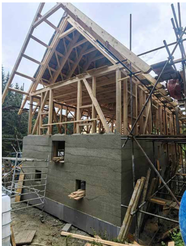
Konopný beton aplikovaný přímo na stavbě
