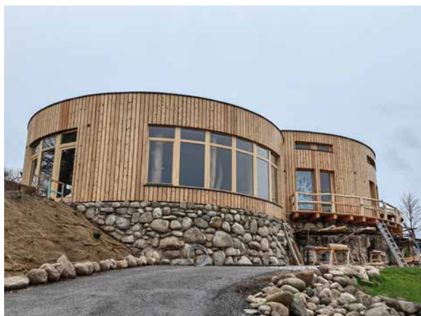
Zahrada živilů: dům z prefabrikovaných panelů z konopného betonu
