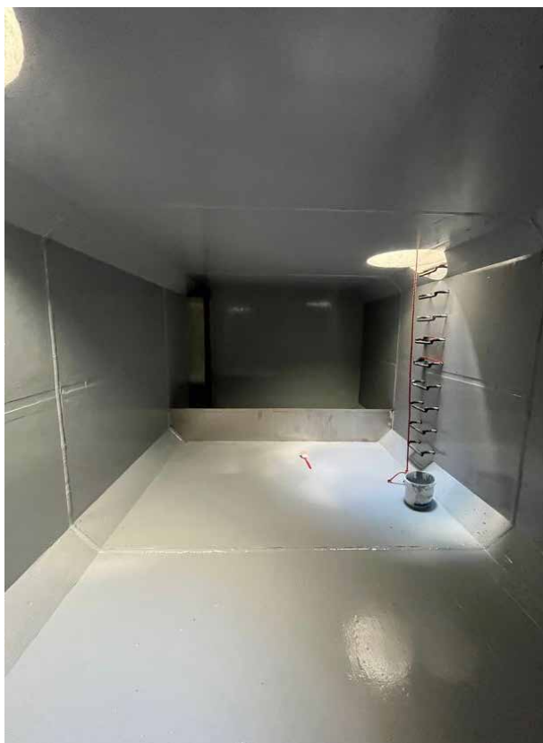
Obr. 1 – Pohled do rámové nádrže s ochranným nátěrem
