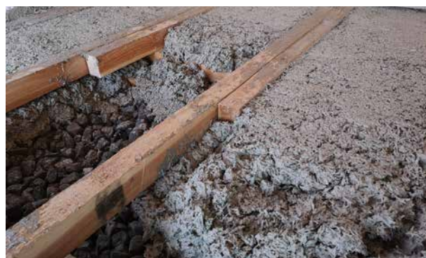
Kombinace pěnoskla a konopného betonu při izolaci podlah
