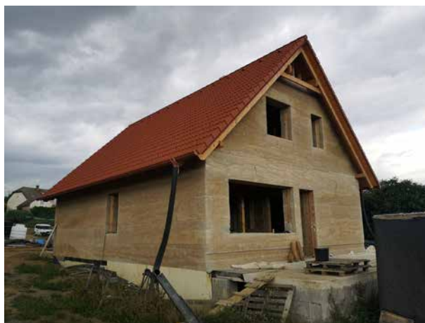
Hrubá stavba z konopného betonu
