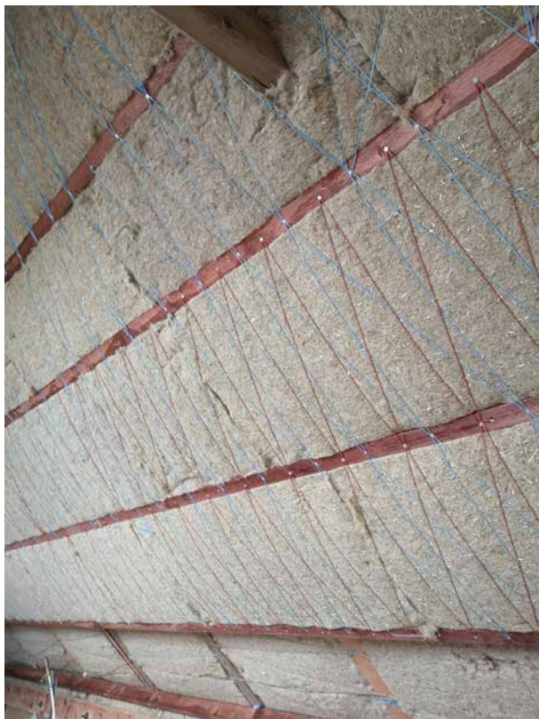
Zateplení střechy – konopná izolace flex
