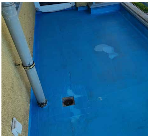
Obr. 2 – Dvousložková hydroizolační hmota HI 2K spolehlivě izoluje balkony a terasy. Nanáší se ve dvou vrstvách kolmo na sebe – první štětcem či válečkem, druhá ocelovým hladítkem
