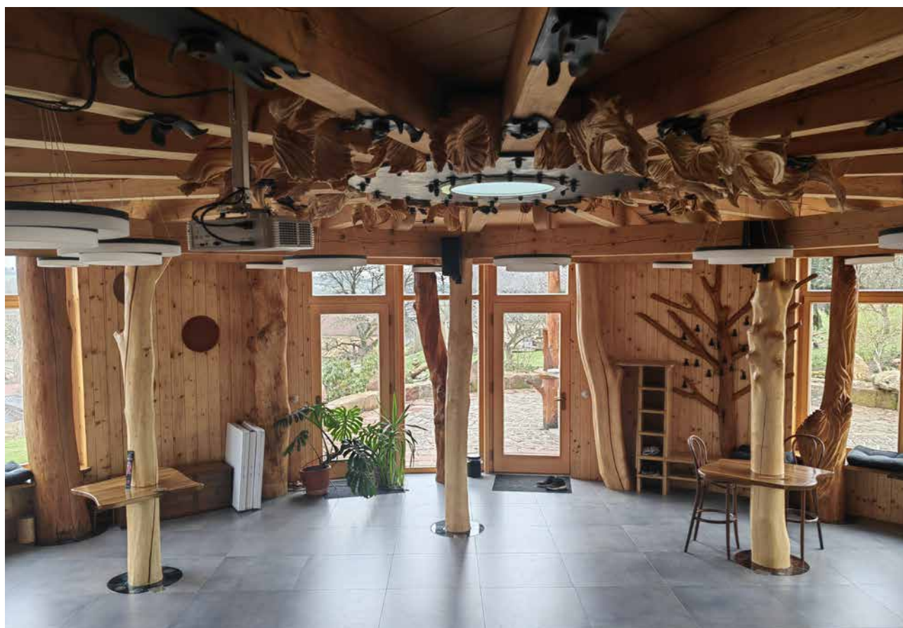
Obložení ošetřené konopným olejem na stavbě z prefabrikovaných panelů z Hempcrete
