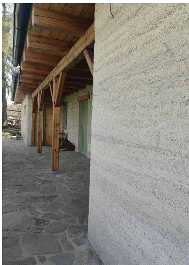
Monolitická konstrukce z Hempcrete
